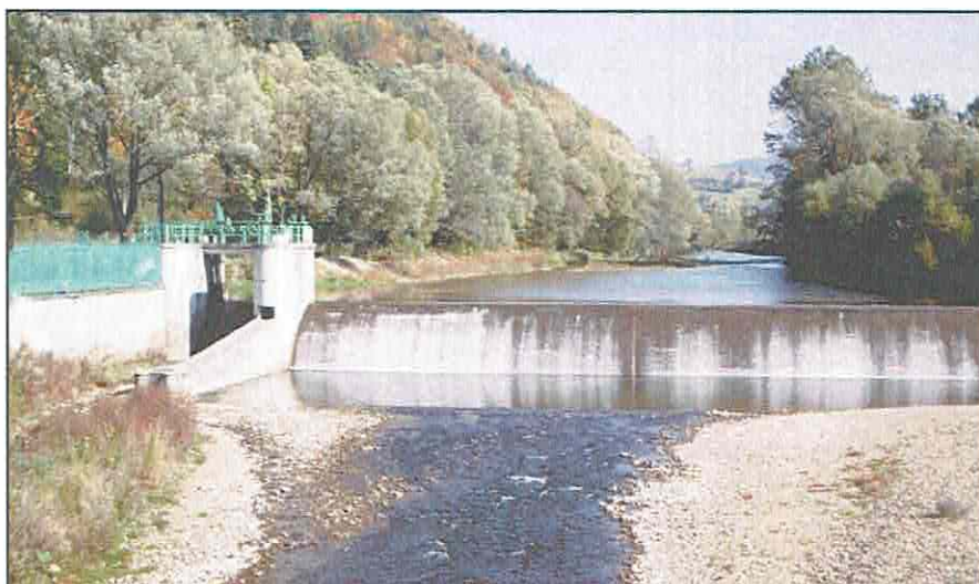
Fot. 5. Betonowy jaz piętrzący na rzece Koszarawa
