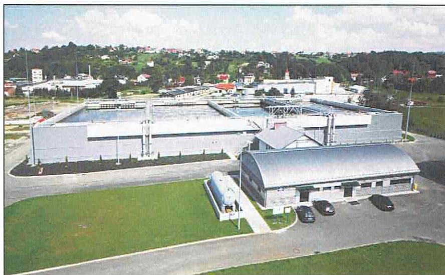
Fot. 3. Widok na sterownię i reaktory C-TECH
