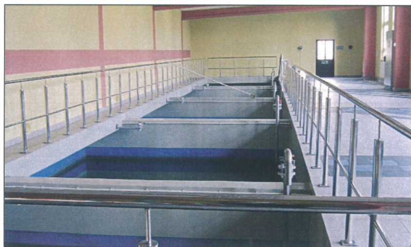
Fot. 2. Komory filtracyjne
