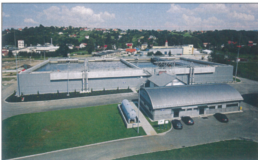
Fot. 3. Widok na sterownię i reaktory C-TECH
