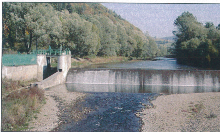
Fot. 5. Betonowy jaz piętrzący na rzece Koszarawa
