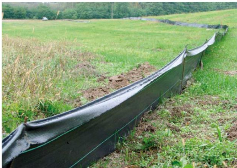
Ryc. 13. Przykładowe ogrodzenie tymczasowe z geowłókniny (źródło: Kurek i inni, 2011, Poradnik ochrony płazów)
