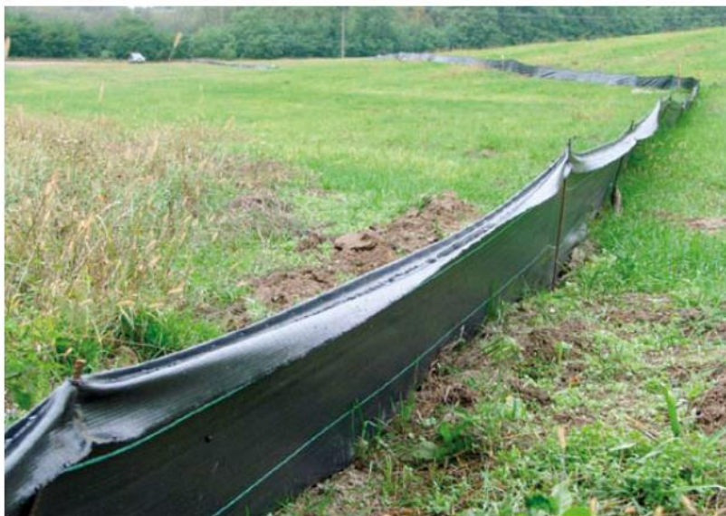
Ryc. 1 Przykładowe ogrodzenie tymczasowe z geowłókniny (źródło: Kurek i inni, 2011, Poradnik ochrony płazów)
