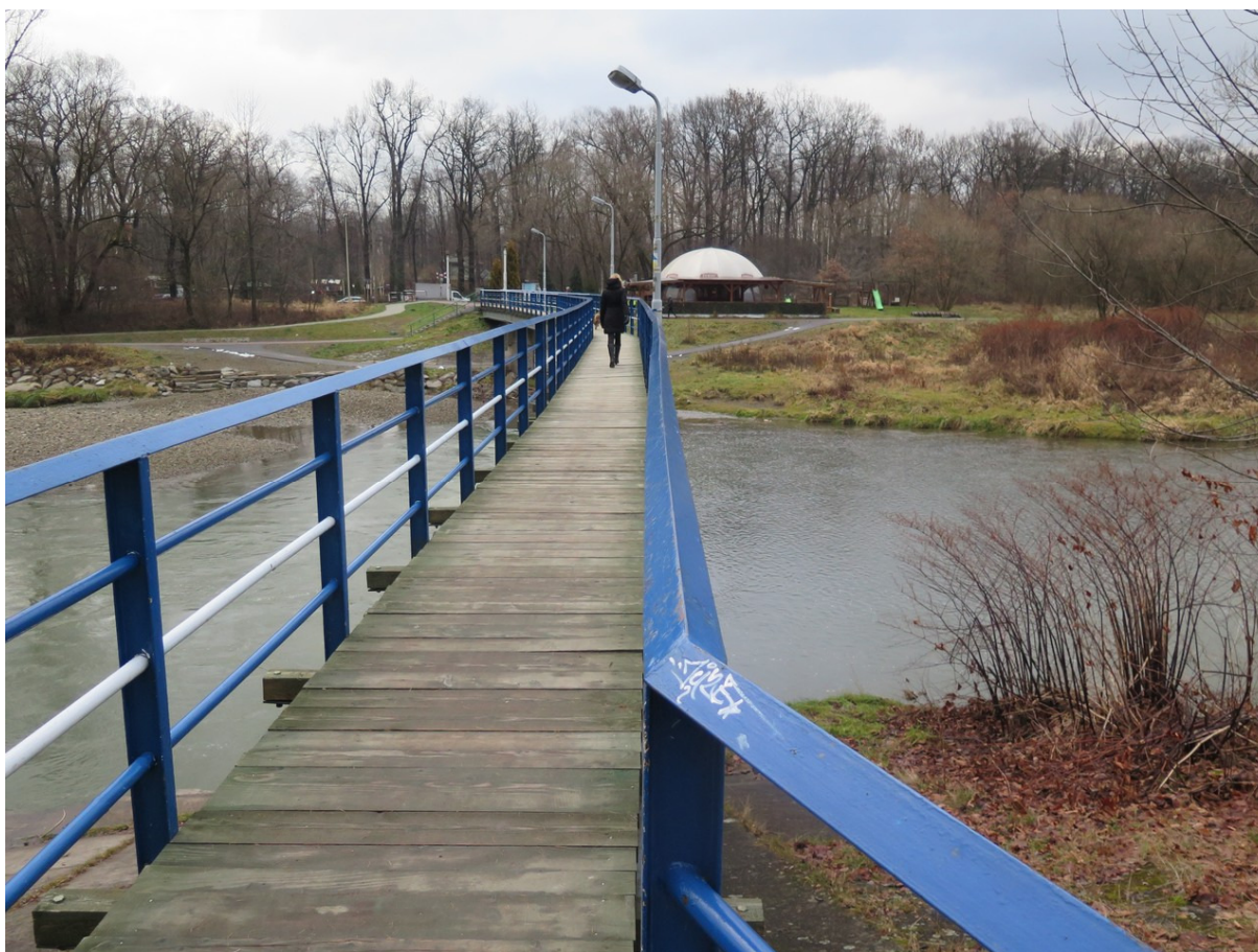
Fot. 2 Pomost istniejącej kładki w widoku z lewego brzegu.
