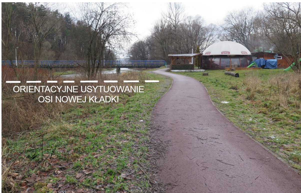
Fot. 8 Ścieżka dydaktyczna na prawym brzegu powyżej istniejącej kładki.
