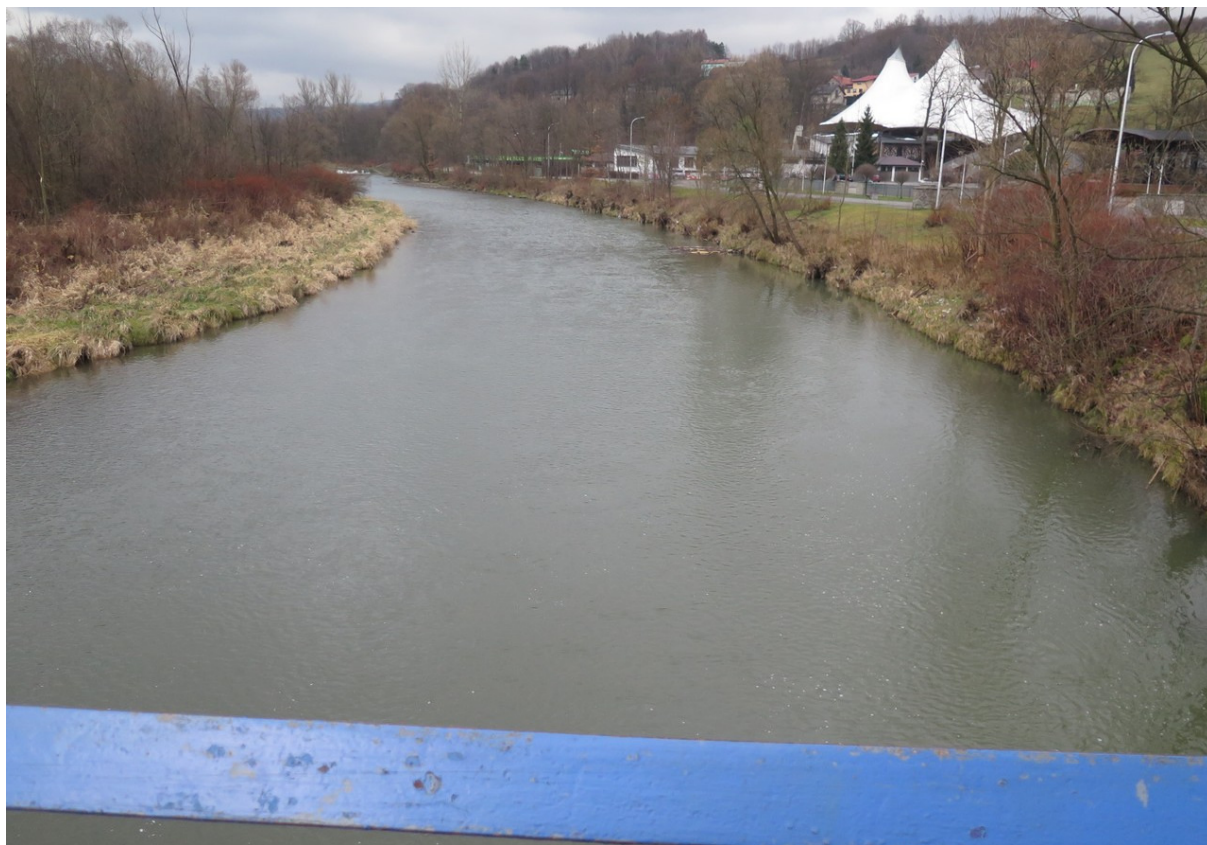
Fot. 14 Koryto rzeki w rejonie planowanej inwestycji.
