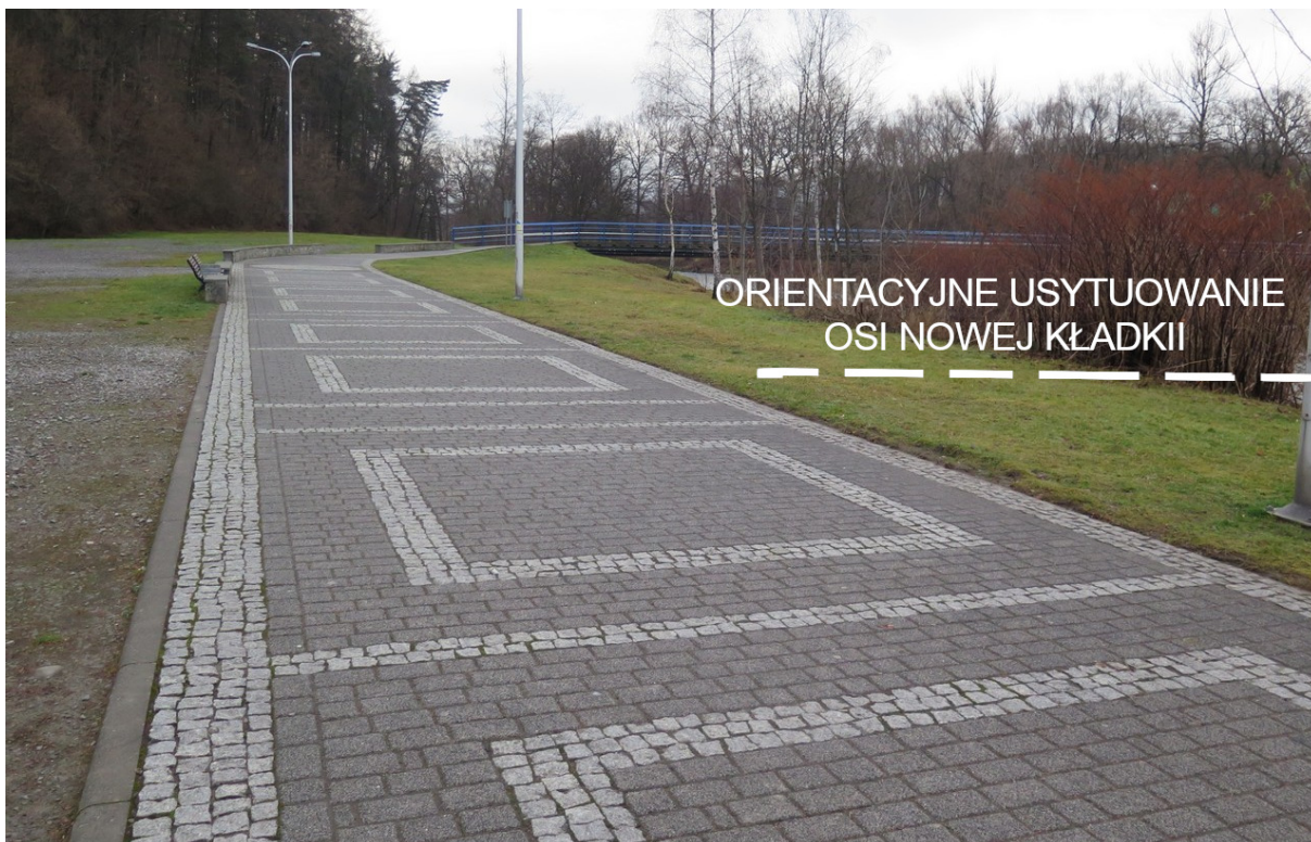
Fot. 12 Dojście do istniejącej kładki na lewym brzegu.
