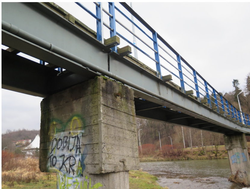
Fot. 4 Elewacja kładki od strony dolnej wody - widoczna jedna rura osłonowa urządzeń obcych.
