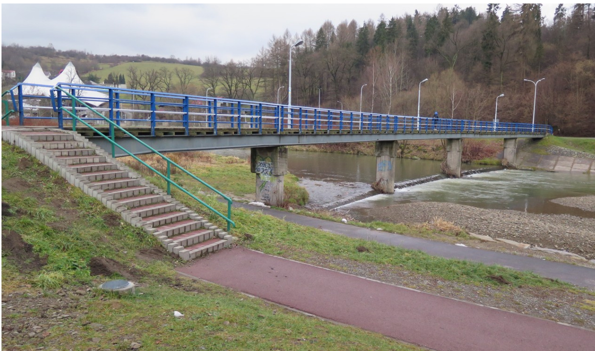
Fot. 1 Widok istniejącej kładki z prawego brzegu od strony dolnej wody. Na pierwszym planie wejście na kładkę ze ścieżki przyrodniczo-dydaktycznej.
