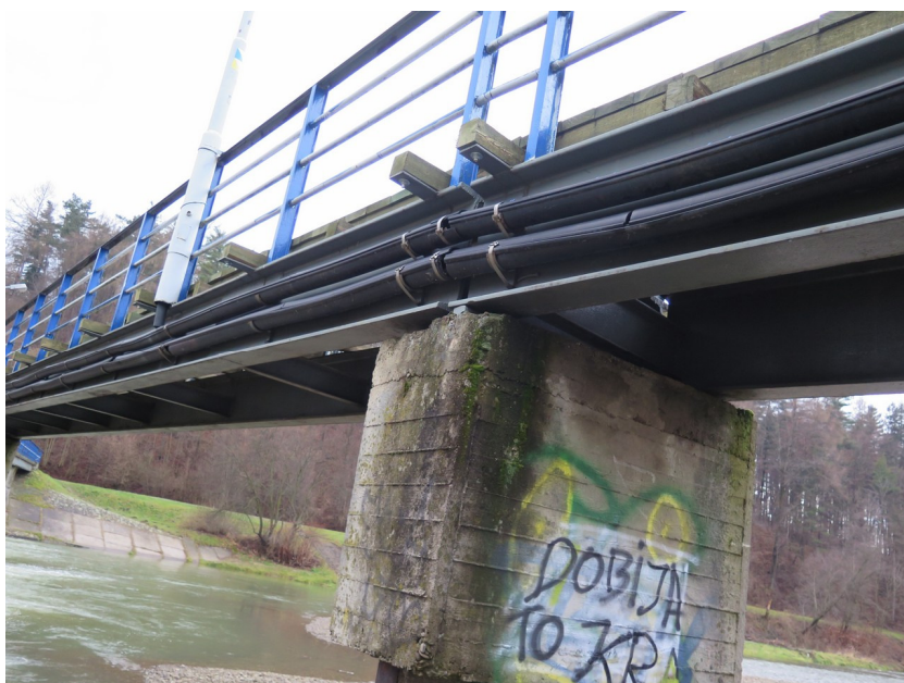
Fot. 5 Elewacja kładki od strony dolnej wody - widoczne dwie rury osłonowe urządzeń obcych.
