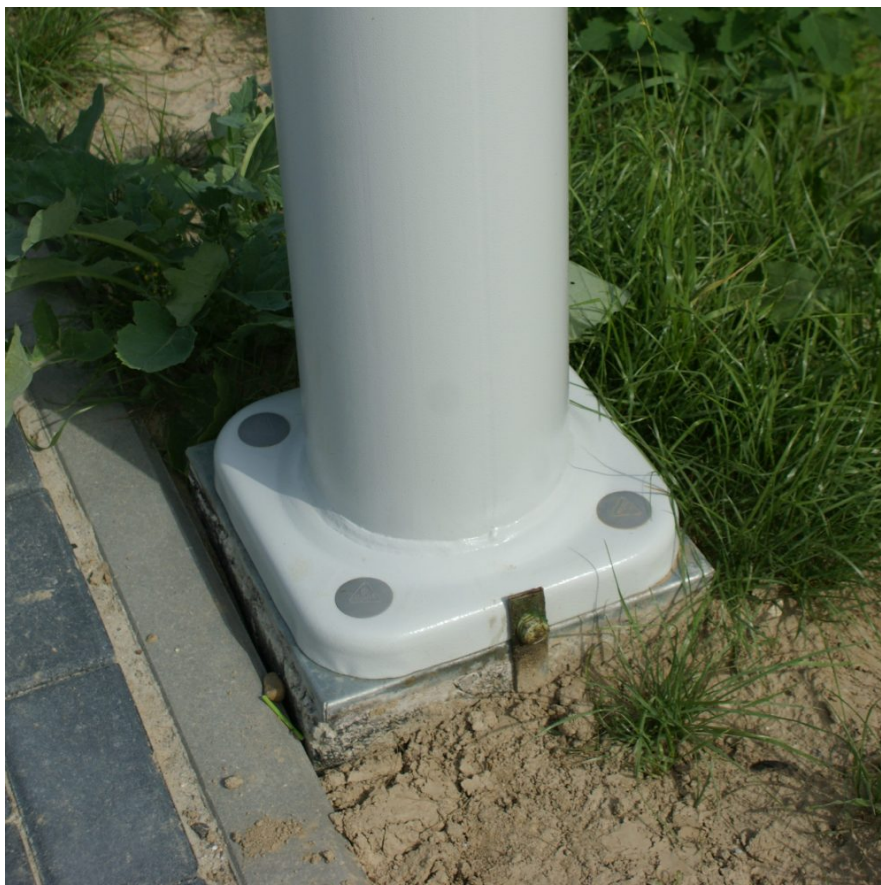
Fundament i detal mocowania słupa do podłoża
