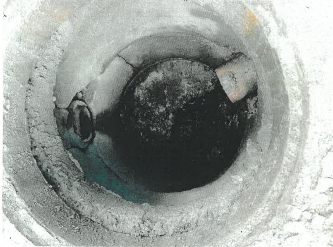
Zdj.1 i 2. Studzienki rewizyjne z widocznymi wylotami i naniesionym szlamem.
