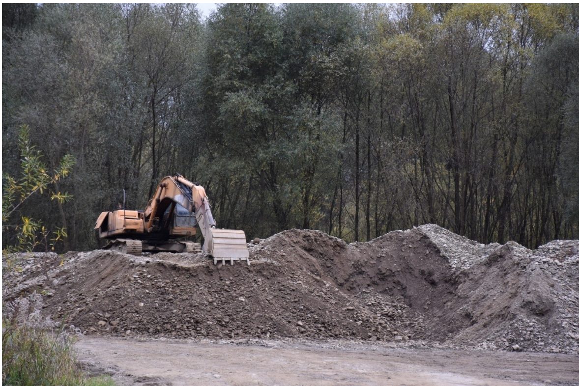
Fot. 4 Prace nad brzegiem Soly.
