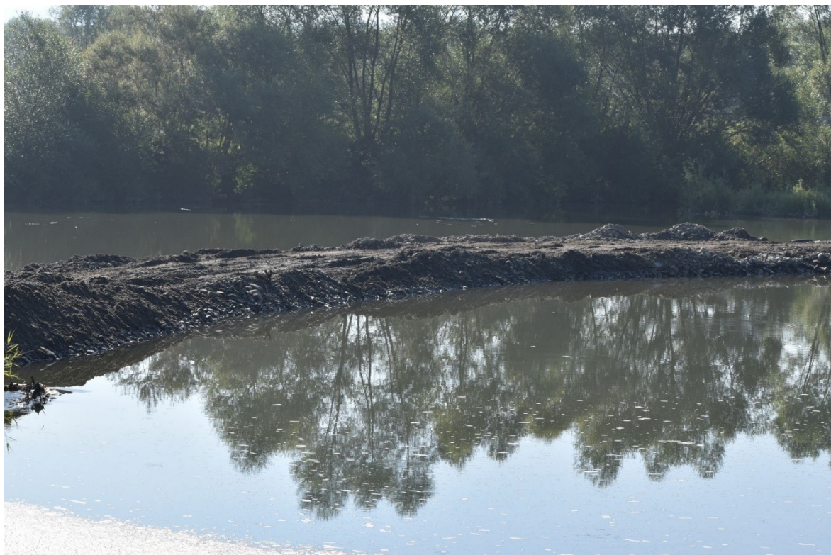
Fot. 2 Tymczasowa droga na Sole.
