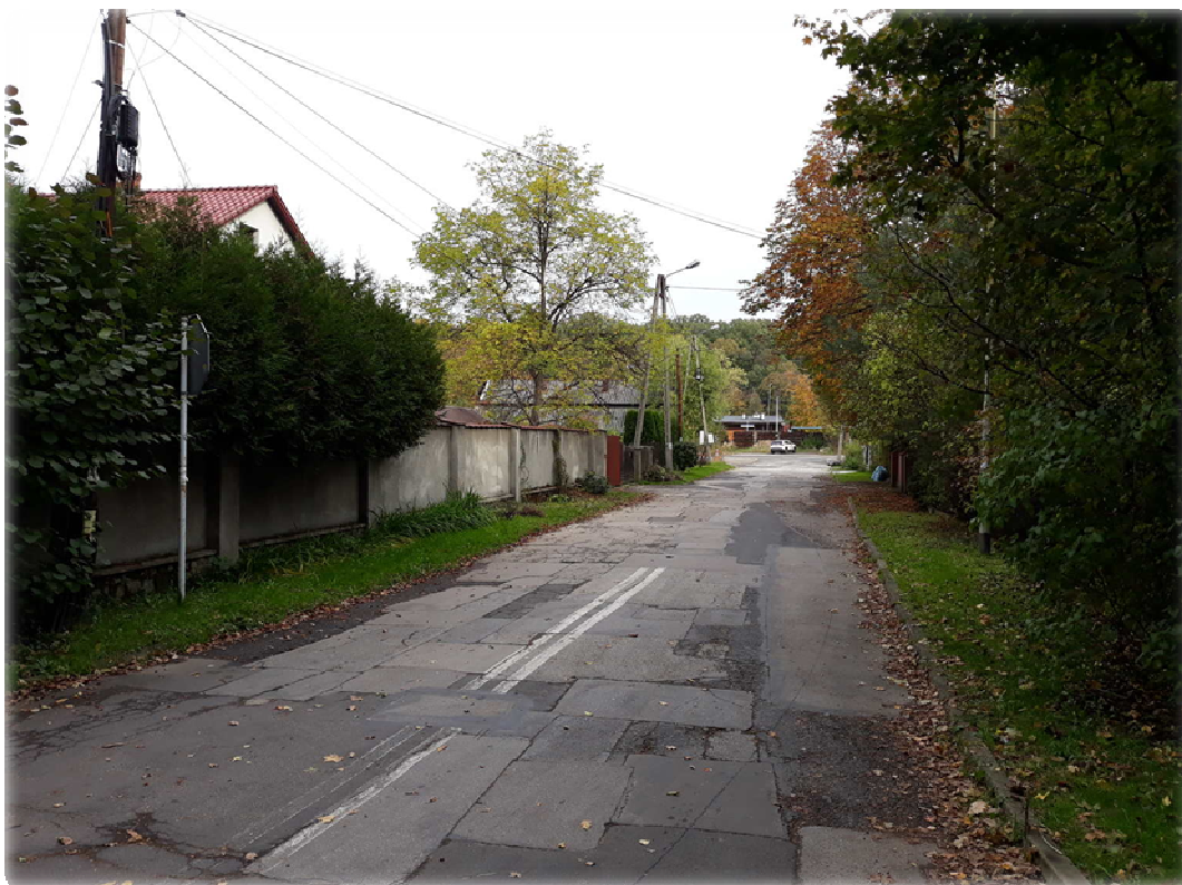
Zdjęcie 3) Widok drogi gminnej ul. Żwirowej (odcinek nr 1) w kierunku ul. Piotra Skargi
