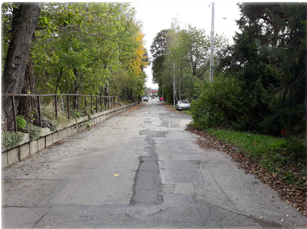
Zdjęcie 4) Widok drogi gminnej ul. Żwirowej (odcinek nr 1) w kierunku ul. Piotra Skargi
