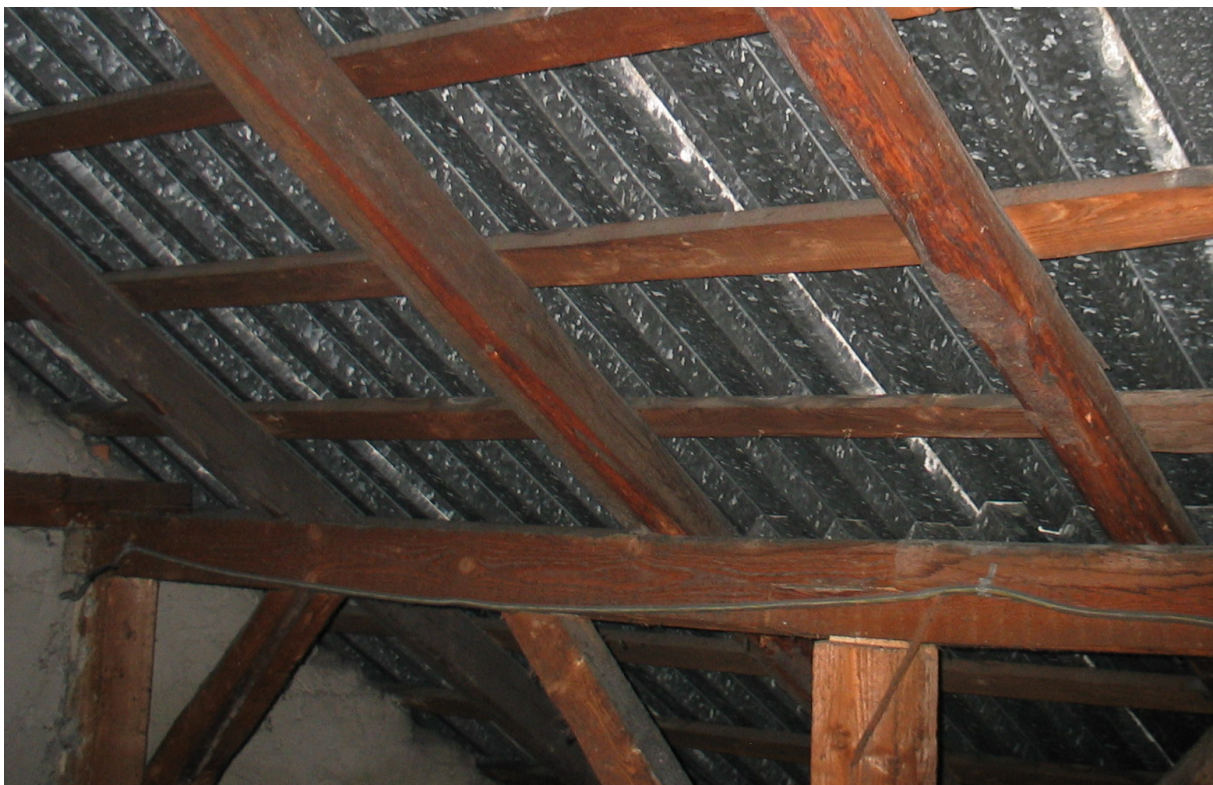
Rys. 2.1 Wieżba dachowa o konstrukcji płatwiowa-kleszczowej
